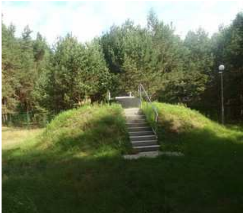
Zdjęcie 2. Ujęcie wody na SUW w Czersku (studnia 2)
