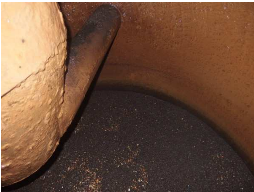
Zdjęcie 6. Powierzchnia złoża w Filtrze nr 3 - odżelaziacza
