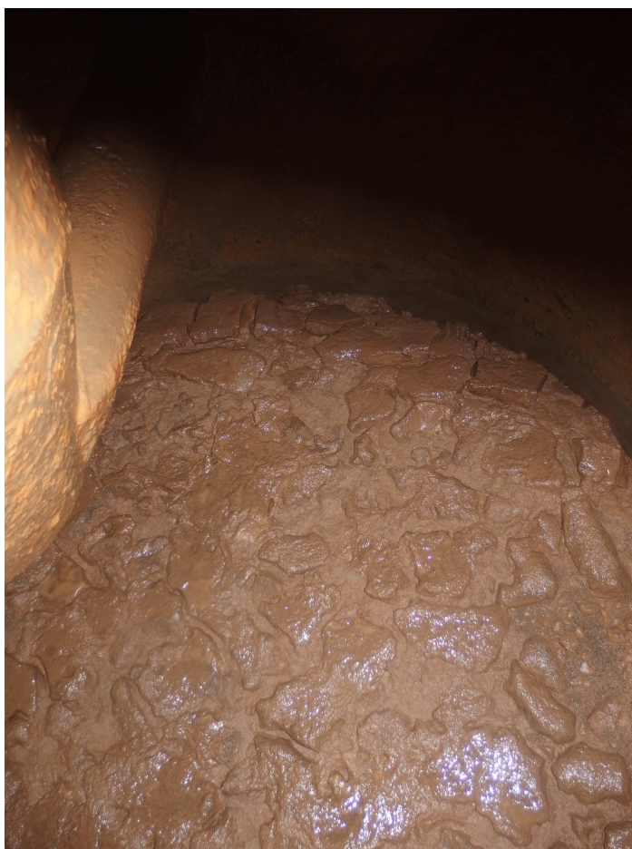
Zdjęcie 8. Powierzchnia złoża w Filtrze nr 4 - odmanganiaczu
