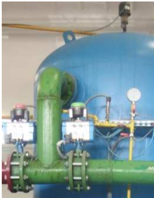
Zdjęcie 3. Wpięcie rurociągu sprężonego powietrza przed filtr ciśnieniowy
