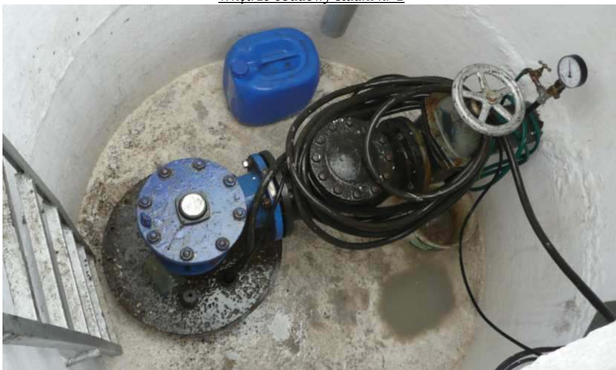
Wnętrze obudowy studni nr 2
