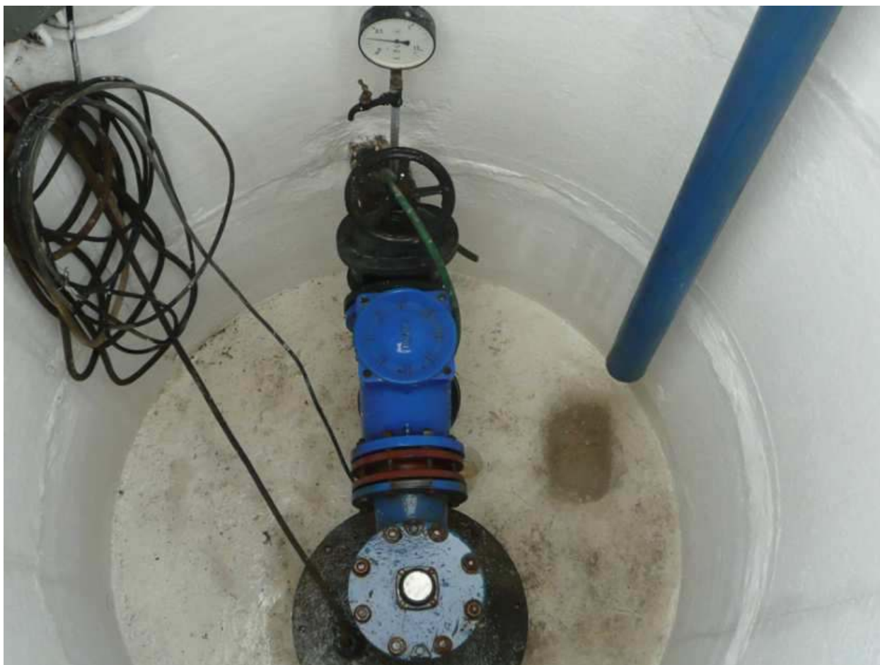
Wnętrze obudowy studni nr 1
